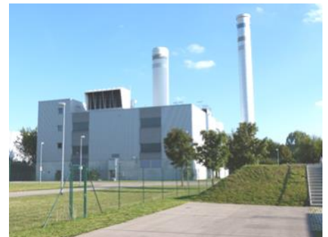
Gasturbinen-Heizkraftwerk in Augsburg-Lechhausen (Foto: Ralf Bendel)
