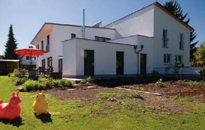
EFH / Lechhausen Augsburger Holzhaus GmbH
