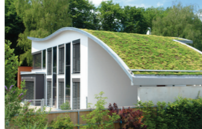
EFH / Hochzoll info@architekt-friedl.de
